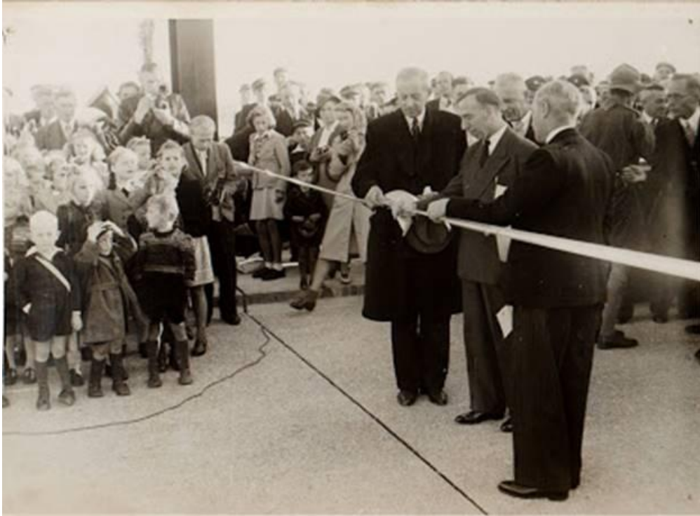
Ir. F.S. Langemeijer (links) bij de heropening van de brug bij Hattem over de IJssel na het herstel van de oorlogsschade.
